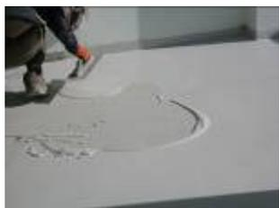
Sulla superficie opportunamente primerizzata, quando secco al tatto, posa in opera di **rivestimento elastoplastico** bicomponente, impermeabile, anticorrosione, atossico, flessibile, antifessura. La prima mano di prodotto dovrà essere applicato a lama per 1 mm di spessore.
